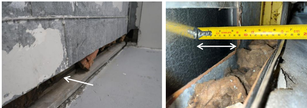
Mur rideau d'origine encore en place (avec de l'isolant dans les panneaux tympans) derrière celui installé à la fin des années 1990
