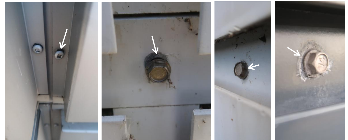
Panneaux en aluminium faits pour durer 100 ans / système de fixation déjà « fatigué » après 10 ans
