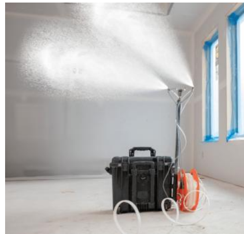
Scellant pulvérisé dans environnement pressurisé Réf. : https://aeroseal.com/canada-francais/
