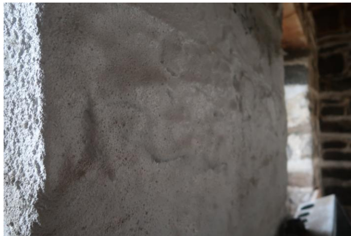
Membrane pare-air liquide sur enduit
