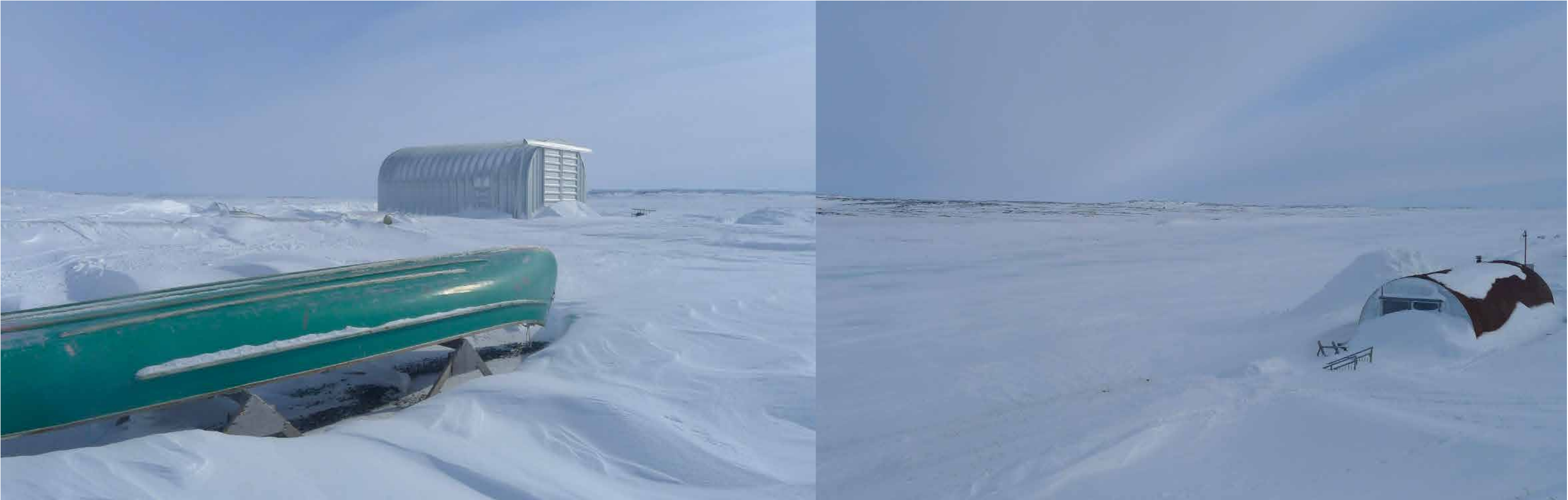
Entreposage froid Village nordique de Puvirnituk
