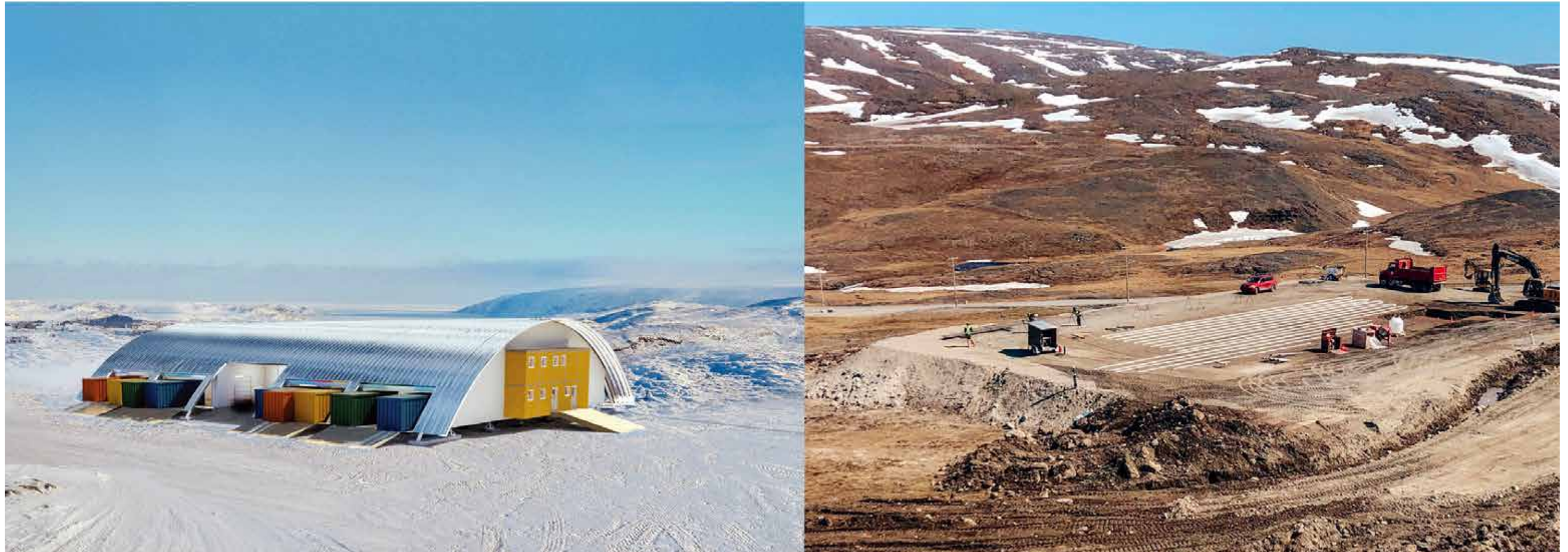
Entrepôt multifonctionnel Office d'habitation du Nunavik Village nordique de Salluit
