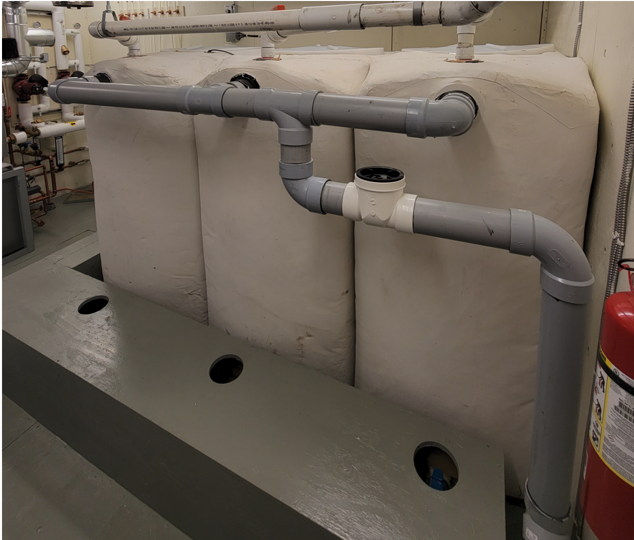
Réservoirs de stockage d'eau potable (gauche) et d'eau usée (droite) au Nunavik (Photos prises à Salluit et à Kangiqsujaq)
