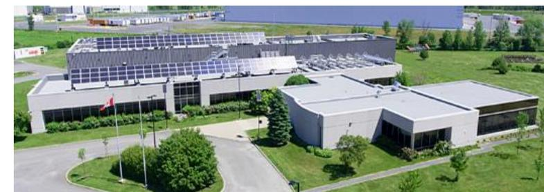
Source : Système PV de 40 kW ajouté au toit du centre CanmetÉNERGIE à Varennes.
