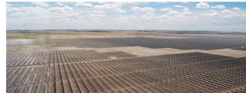
Source : Vulcan County, Alberta, 465 MW, Système PV au sol composé de modules bifaciaux avec suivi mono-axe
