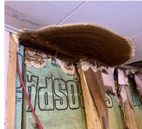
Mérule pleureuse dans un sous-sol fini
