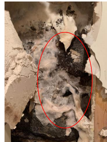
Exemple de mycélium qui se propage sur de la pierre entre deux lattes de bois
