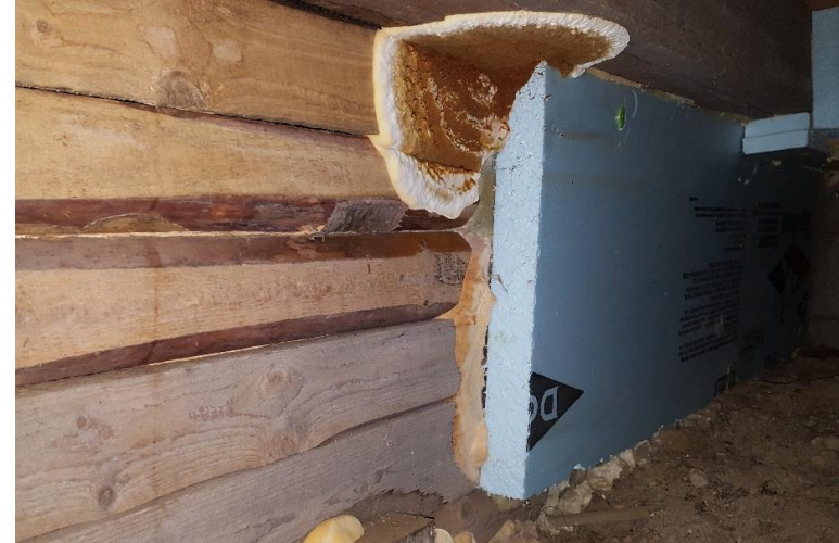
Mérule pleureuse dans un vide sanitaire (MPQ)
