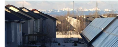
Communauté solaire de Drake Landing (AB) Capteurs solaires, stockage thermique, chaudière au gaz Réduction de la consommation d'énergie primaire de 30%
