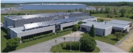
Centre CanmetÉNERGIE à Varennes (QC) Chaudières électrique et au gaz naturel Réduction de la consommation de gaz de 20%
