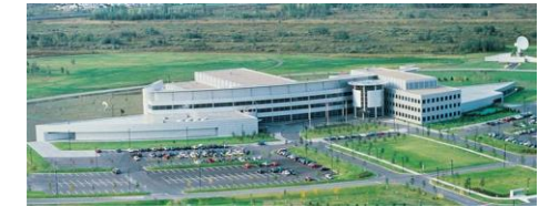
Bâtiment institutionnel, St-Hubert (QC) Chaudières électrique et au gaz naturel Réduction de la consommation de gaz de 51%
