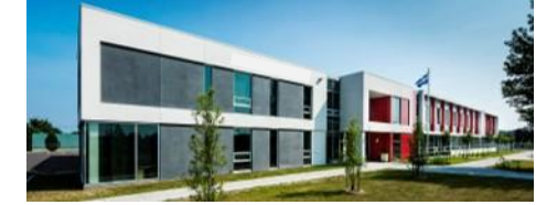
École, région de Montréal (QC) Pompes à chaleur, plancher radiant, stockage d'énergie Réduction de la pointe électrique de 10%
