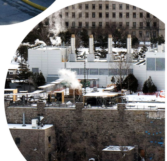
Installation de la centrale temporaire Cliff
