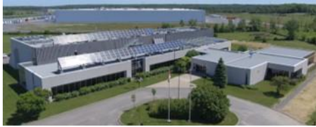
Centre CanmetENERGIE à Varennes (QC) Chaudières électrique et au gaz naturel Réduction de la consommation de gaz de 20%
