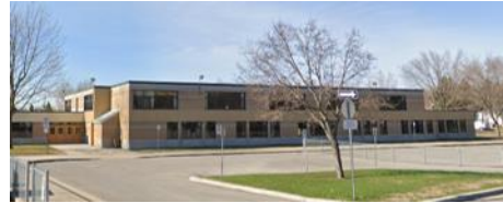
École, région de Montréal (QC) Chaudières électrique et au gaz naturel Réduction de la consommation de gaz de 30%
