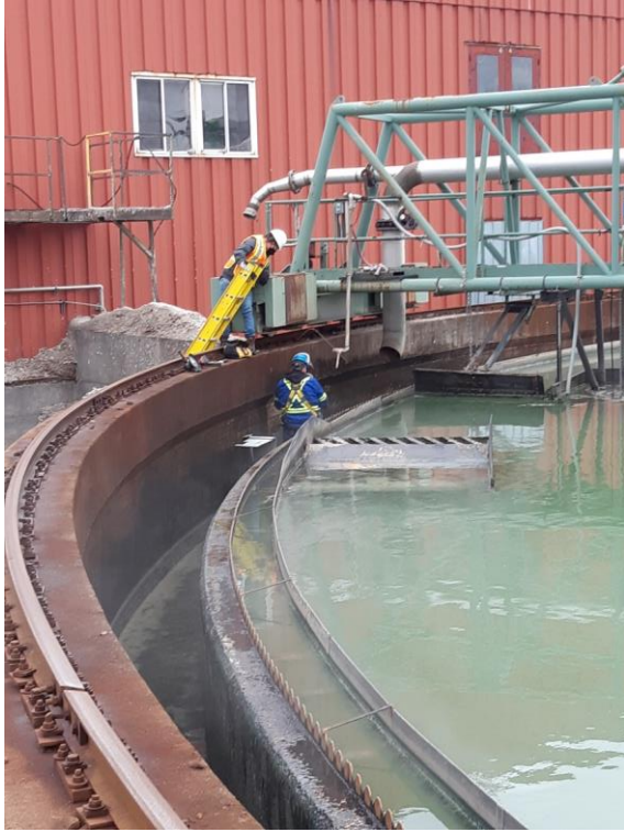
Travaux de modification du clarificateur par BBA
