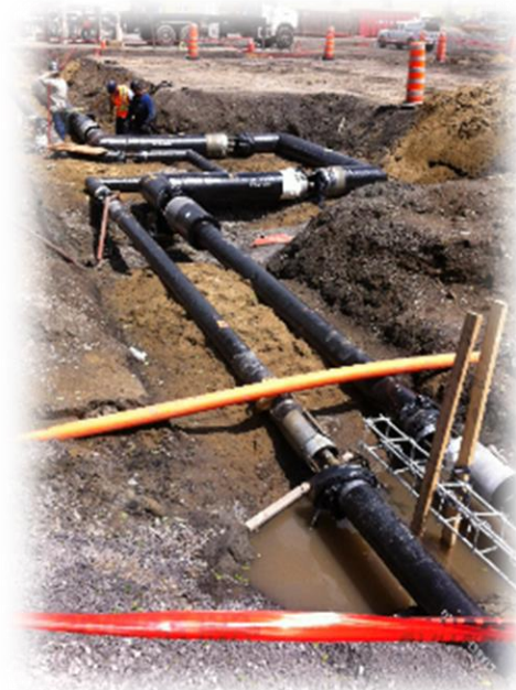
Travaux d'installation de la ligne de vapeur pour GCI (2012)
