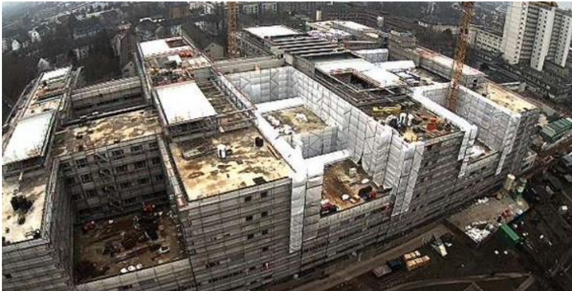
Hôpital Klinikum Frankfurt Hoechst lors de la construction en 2018 Photo: Passive House Institute
