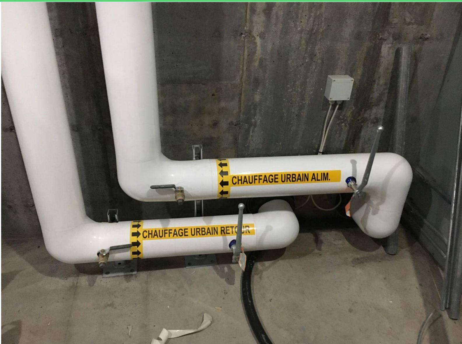
La sous-station d'échange thermique d'une capacité de 1600kW pour le chauffage d'espace et la production d'eau chaude domestique (2 pressions d'opération)
